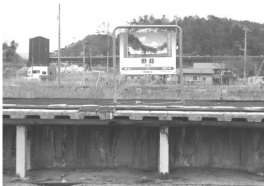
野蒜駅標識奥、線路と平行に写るのがベルトコンベヤー
